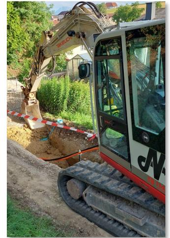
*Bergstraße-Bachweg: Grabungsarbeiten für die Wasserleitung am Pimer-Berg. Parallel zur Wasserleitung wird auch ein Breitband-Internetkabel*
